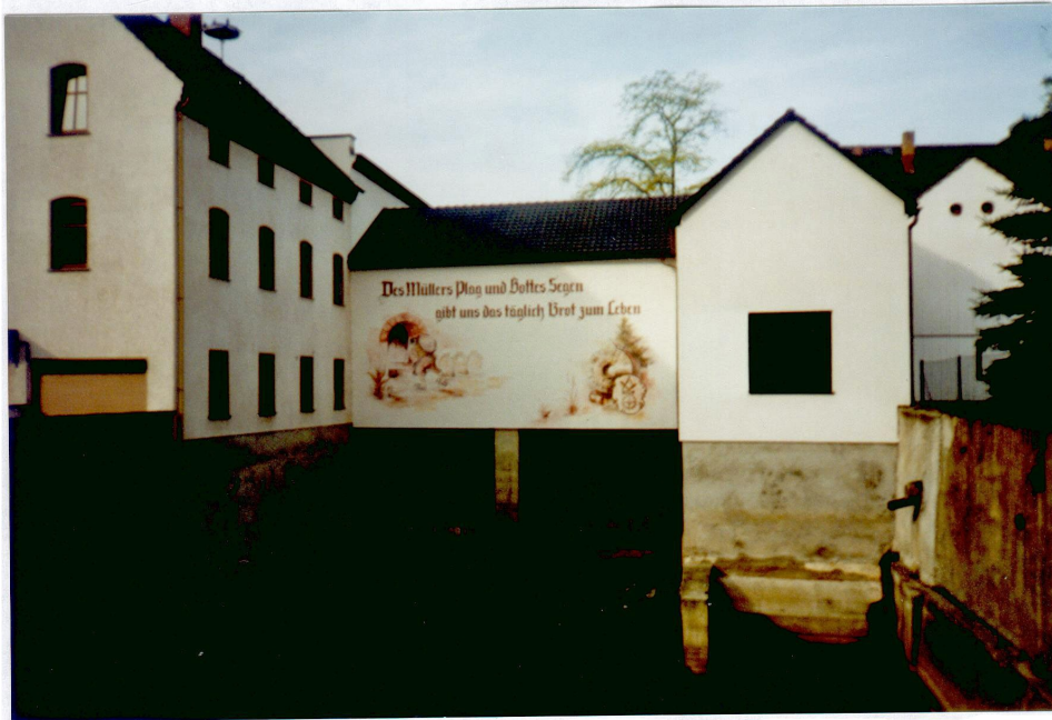
Turbinengebäude mit Mühlgraben
