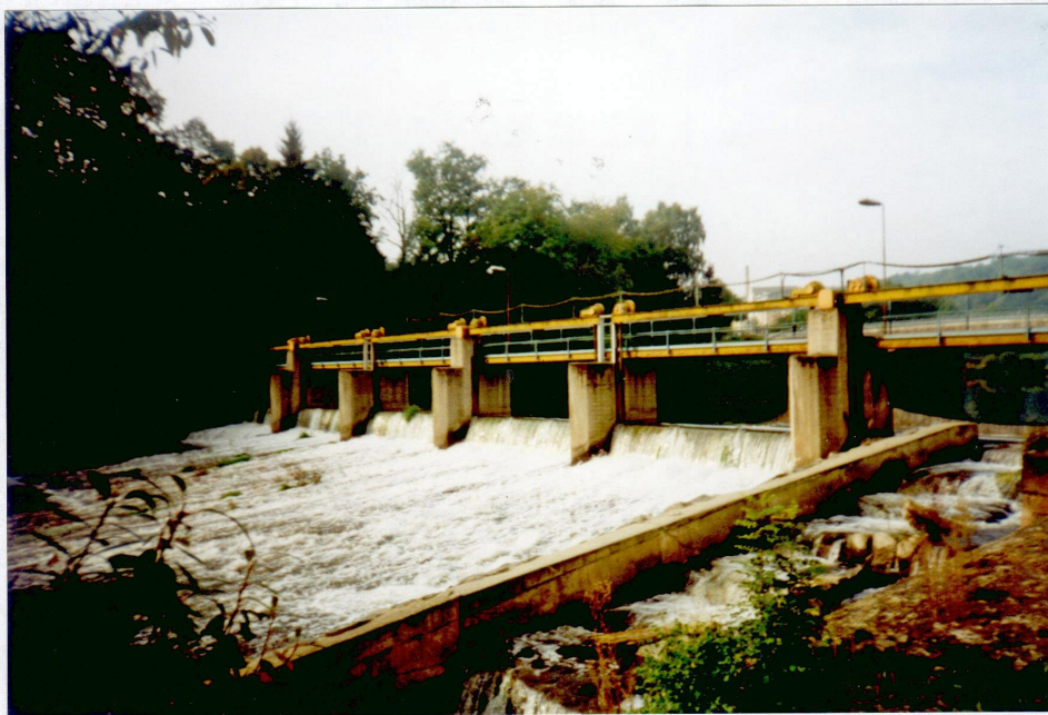
Göhren: Das Wehr mit Fischstrecke
